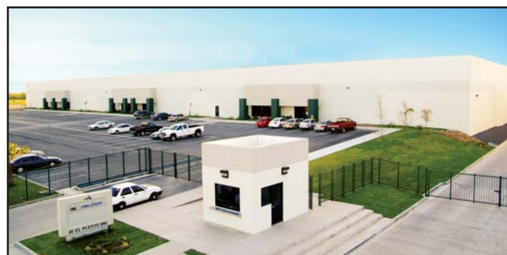
El Puente II Facility - Reynosa, Tamaulipas, Mexico
